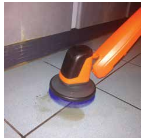
Tegelvloeren en voegen
